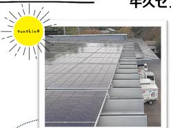
パネルは全部で68枚 太陽光出力:32.64 k W PPA(電力購入契約)という仕組みで設置されました。
