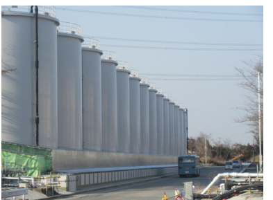
汚水保管用のタンク
