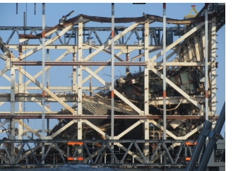
がれきが覆った状態の1号機建屋
