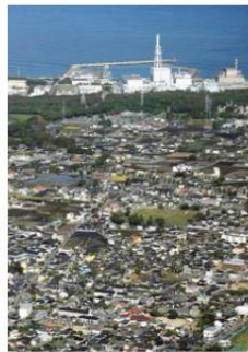
東海第二原発(写真上)と東海村の市街地 2017年2月1日 東京新聞より
